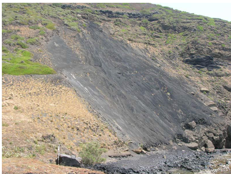
Foto 2 – Dissesto in località Cala Pozzolana di Levante
